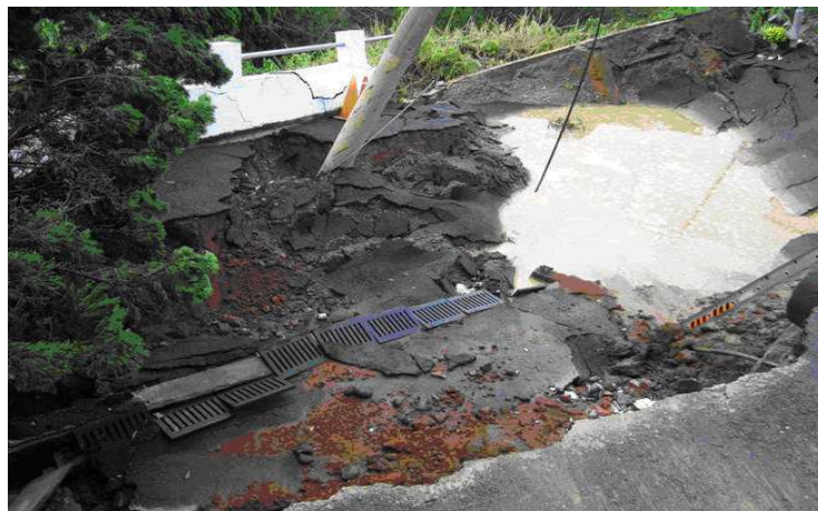
圖 3-11 大雅路二段 386 巷擋土牆塌陷
